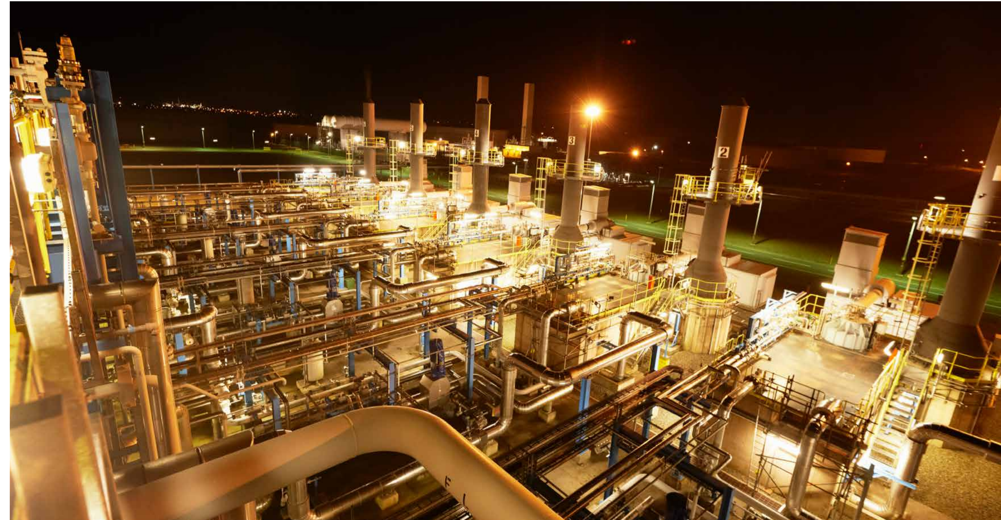
EXISTING DRAGON LNG TERMINAL AT NIGHT
