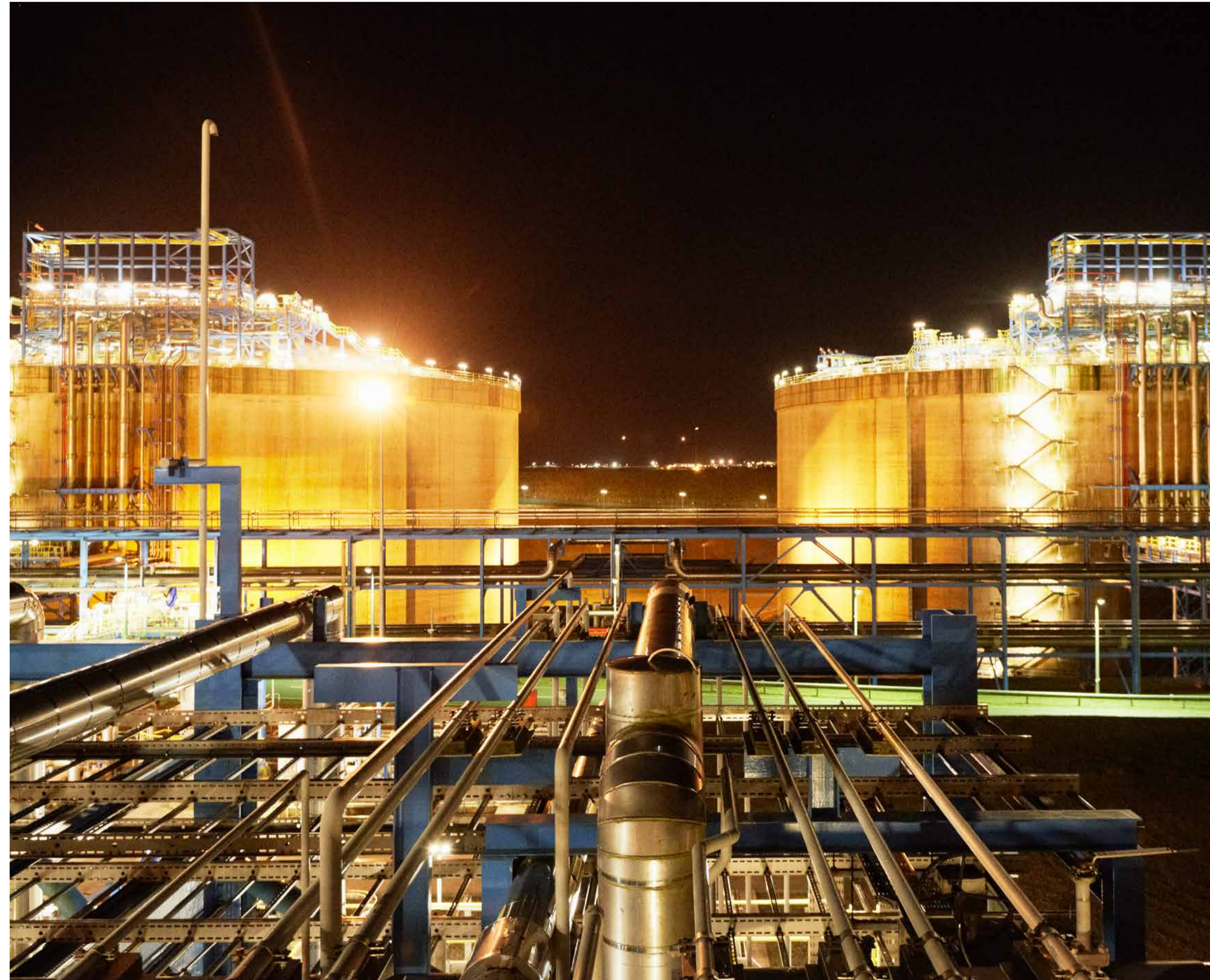
EXISTING DRAGON LNG TERMINAL AT NIGHT
